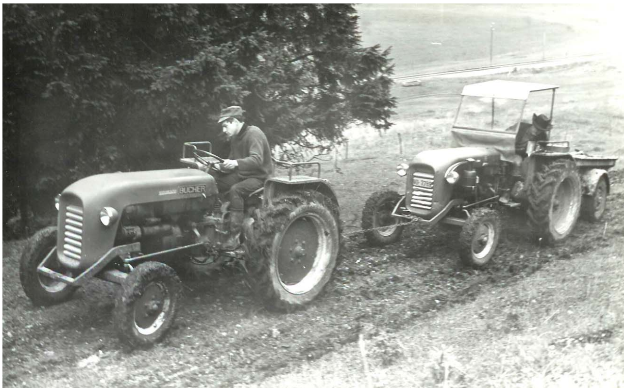
Construction d'un télési aux Roulus au milieu des années soixante.
